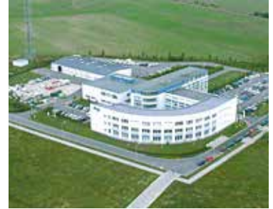
Datacenter Kolkwitz Annhofer Graben 1-3 03099 Kolkwitz
