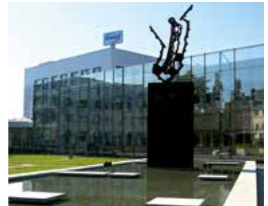
Datacenter Chemnitz Chemnitztalstraße 13 Datacenter Plauen 09114 Chemnitz
