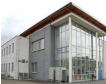
Datacenter Plauen Hammerstraße 68 08529 Plauen
